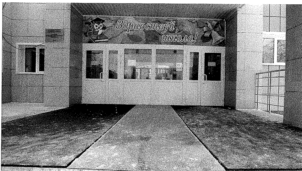
Фотография №8. Входная площадка (перед дверью)
