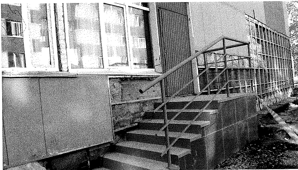
Фотография №23. Эвакуационный выход №4 (лестница наружная)
