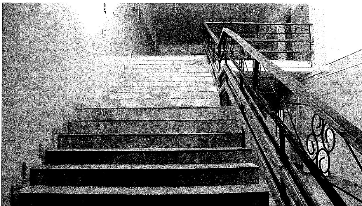
Фотография №18. Лестница на второй этаж (в актовый зал)
