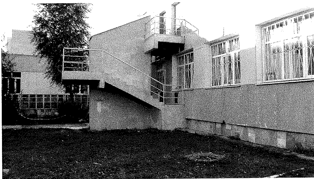
Фотография №24. Эвакуационный выход №5 (лестница наружная)
