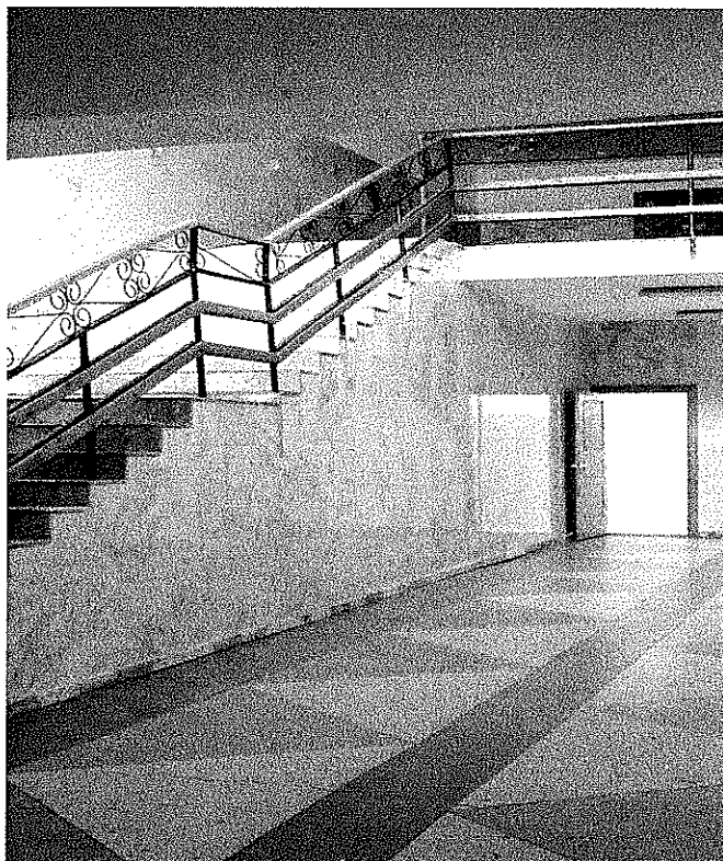
Фотография №17. Лестница на второй этаж (в актовый зал)
