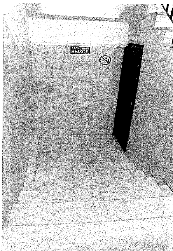
Фотография №20. Пути эвакуации №1 (внутри здания)
