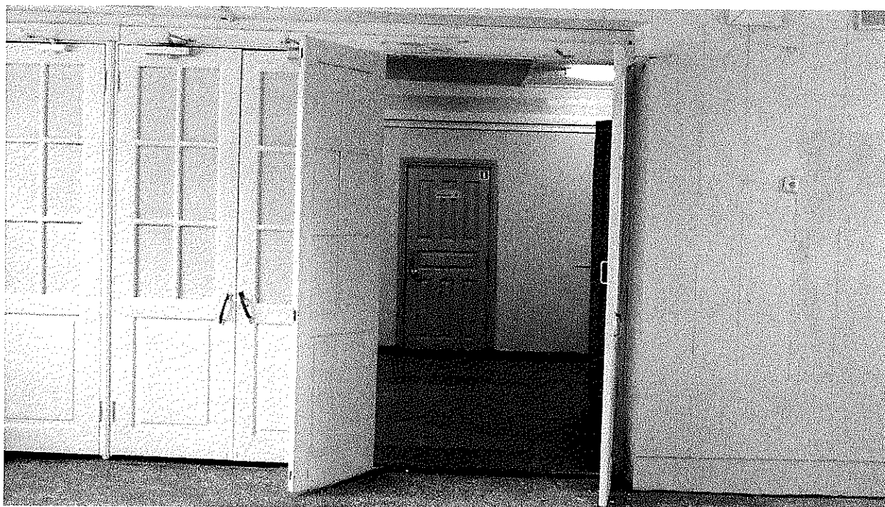
Фотография №19. Дверные проемы (холл)
